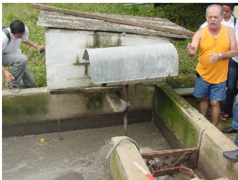
Figura 18. Decantação e separação do material sólido da suinocultura início do processo
