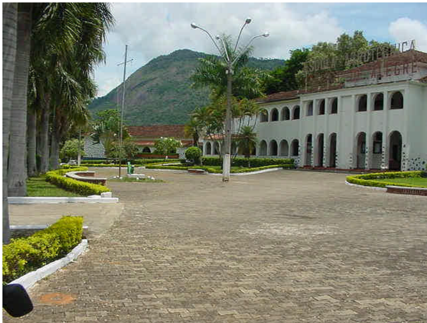
Figura 6. Vista das salas de aulas e setor administrativo
