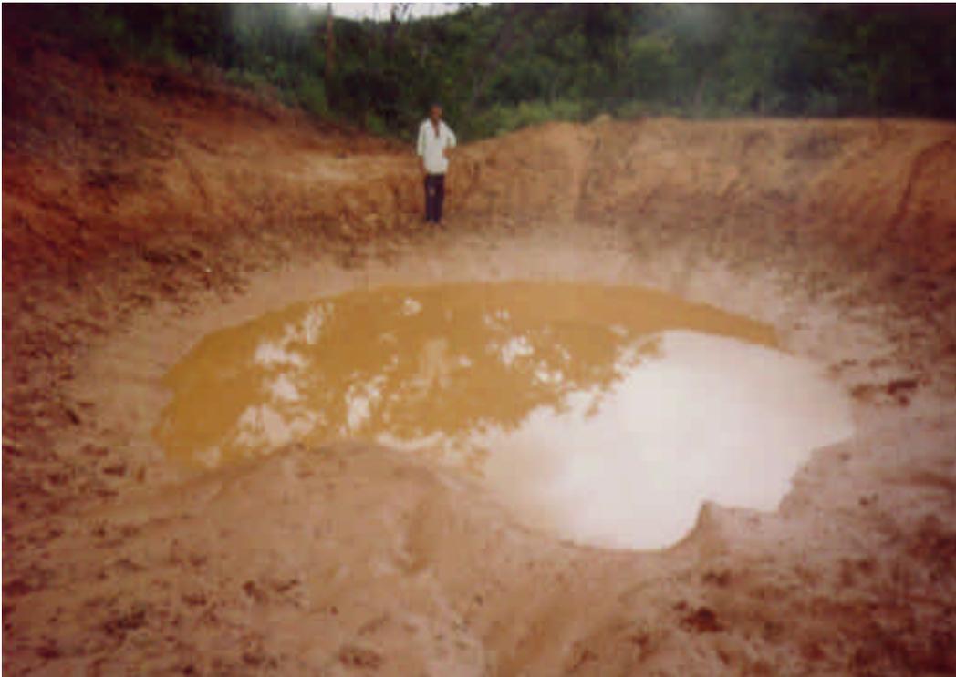
**Figura 04.** Tanque para contenção de enxurrada – Comunidade Bois – Salinas MG.
