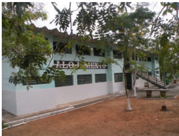
Figura 7: Prédio do internato masculino
