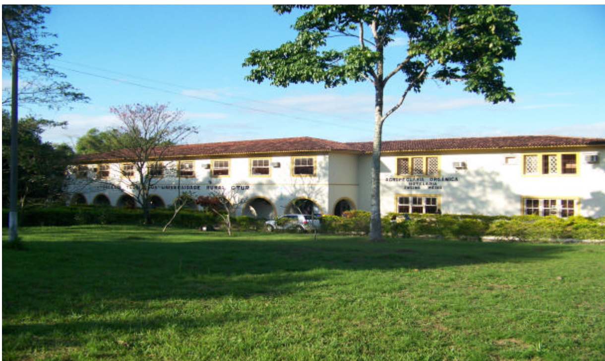
Fig. 07 – Fachada do Prédio Principal do CTUR
