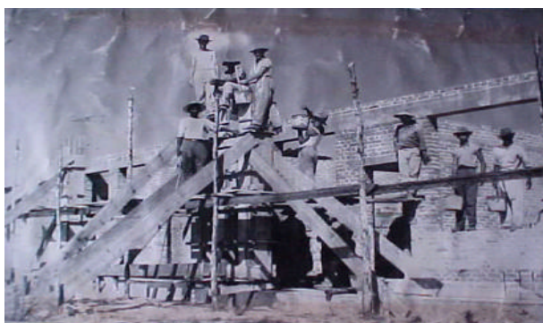
Figura 01 - Escola de Iniciação Agrícola em construção.
