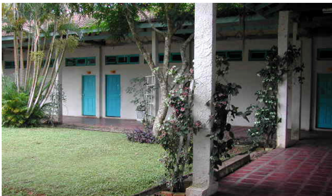
Foto 05 – Vista do bloco de salas de aula anexo ao bloco central.
