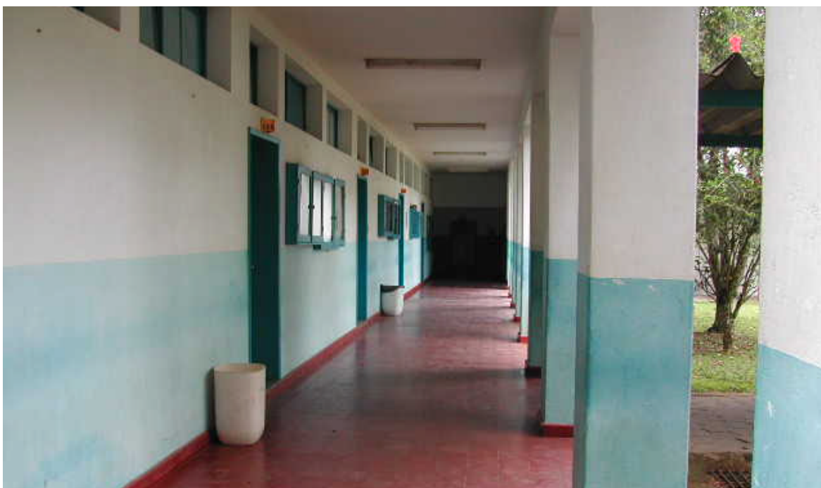
Foto 04 – Vista do corredor externo do bloco central. Acesso às salas de aula.
