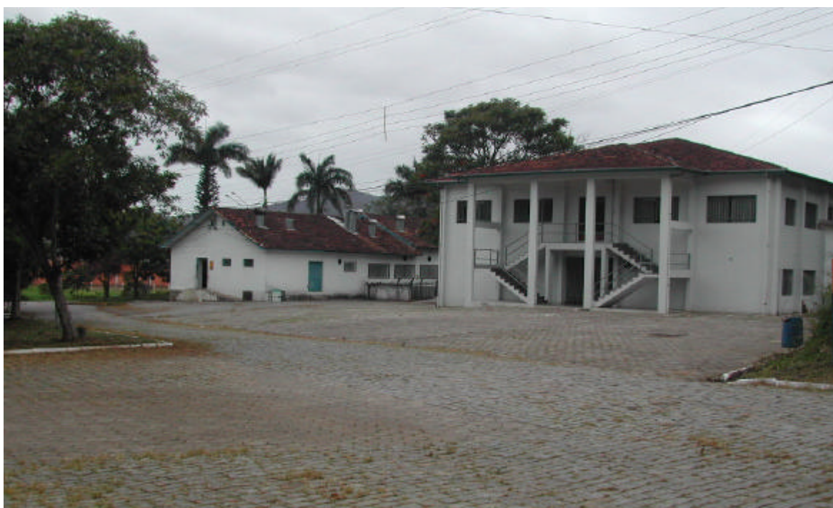
Foto 09 – Vista externa da cozinha a esquerda e do bloco de laboratórios à direita.
