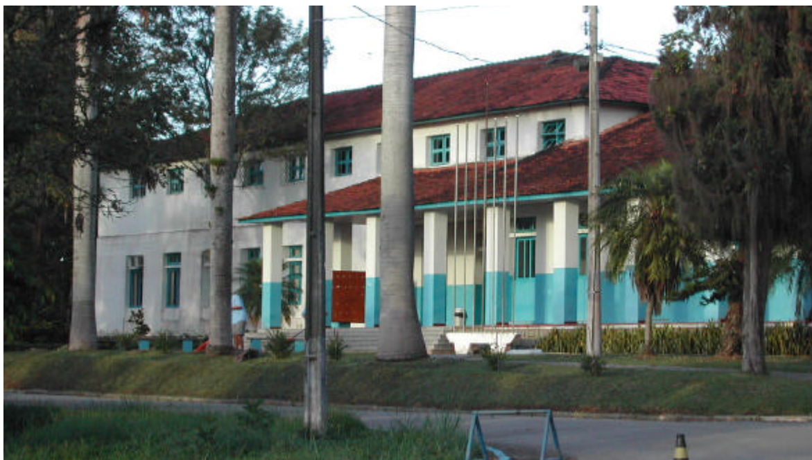
Foto 02 – Vista da fachada do bloco central.
