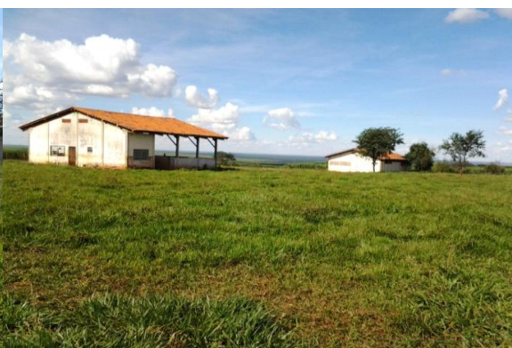
Figura 7 - Setor de zootecnia - instalações
