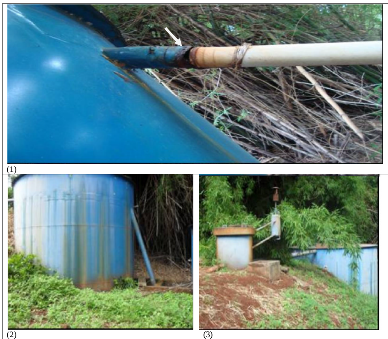
Figura 4.4: (1) Tubulação do sistema de esgoto danificada; (2 e 3) Reator biológico.
