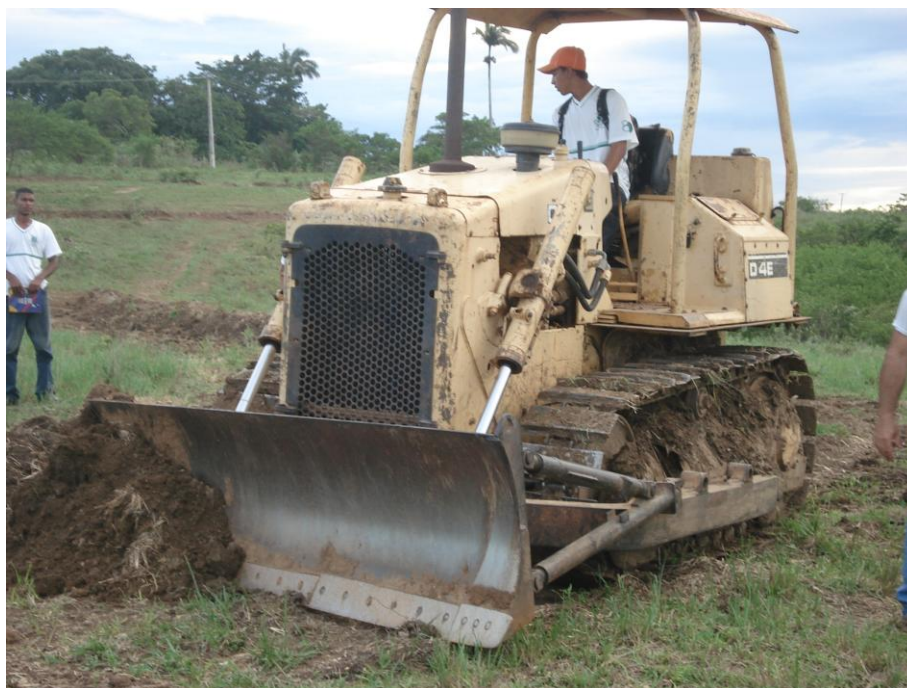
Foto 1: Alunos utilizando trator de esteira na construção do terraço, Unidade Demonstrativa do Projeto de Trabalho/Pesquisa, IFS/Campus São Cristóvão, 2008.
