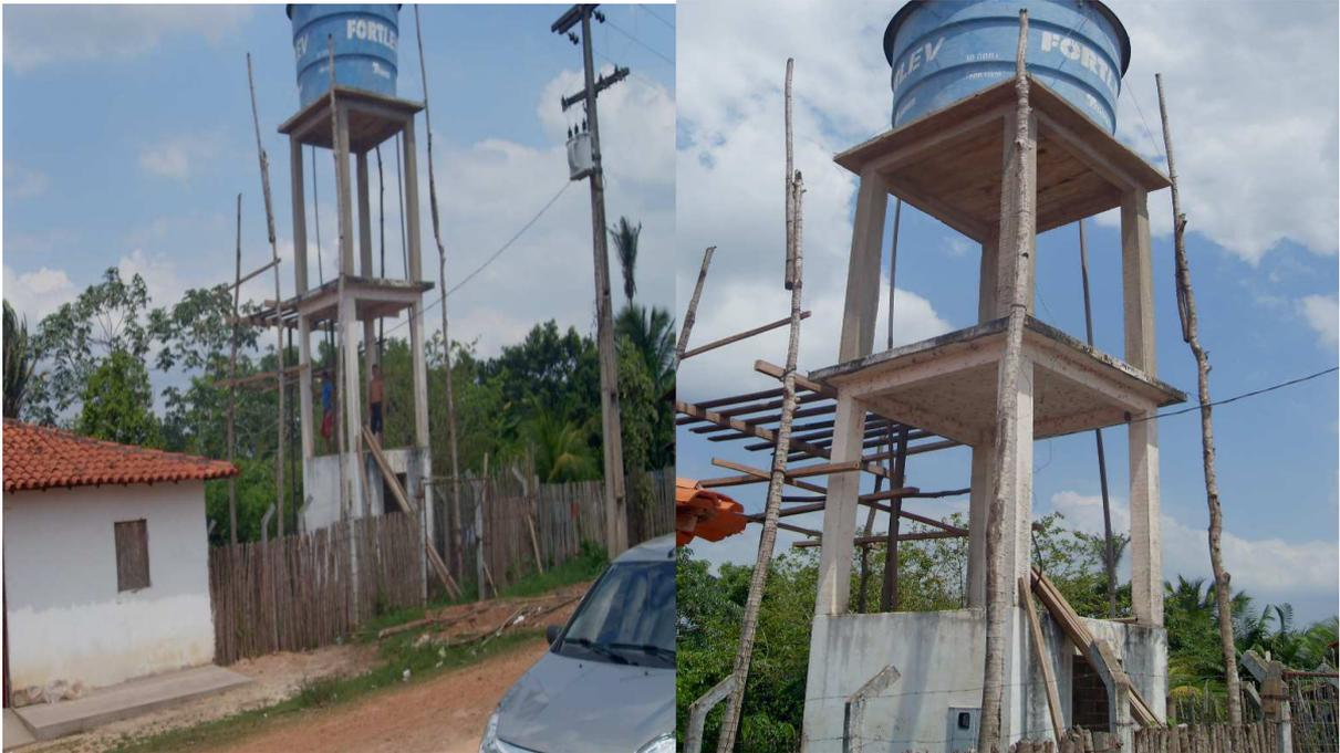
**Figura 46** – Imagem atual da área do reservatório de água do ABE, Zé Doca, Brasil, mostrando a reforma em andamento, inclusive com feitiço complementar de cerca de madeira que foi construída para evitar a presença de animais que antes circulavam normalmente no interior do sistema que possuía apenas cerca de poste de concreto.
