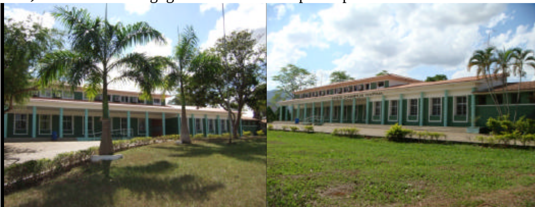
Figura 01, 02 – Prédio Pedagógico do IFES – Campus Itapina
