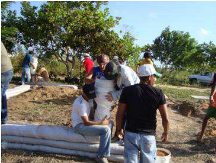
Figura 27 – Enchimento do saco de ráfia em rolo com balde sem fundo
