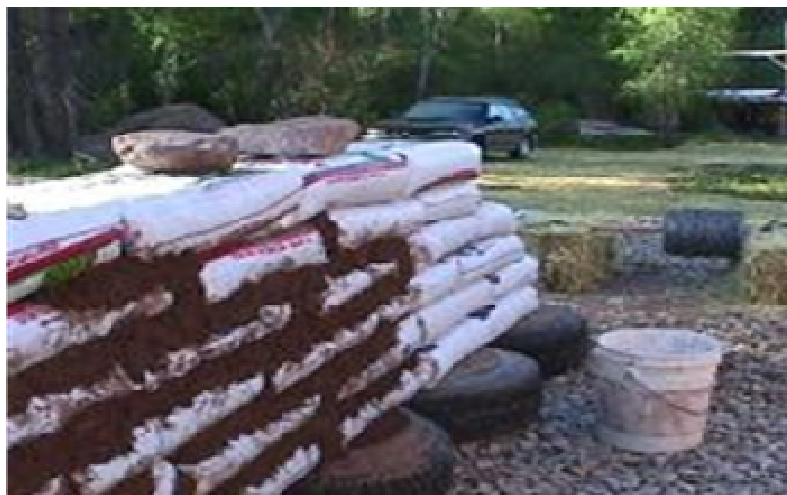
Figura 25 – Fundação para construção com superadobe 5 FONTE: Desconhecida
