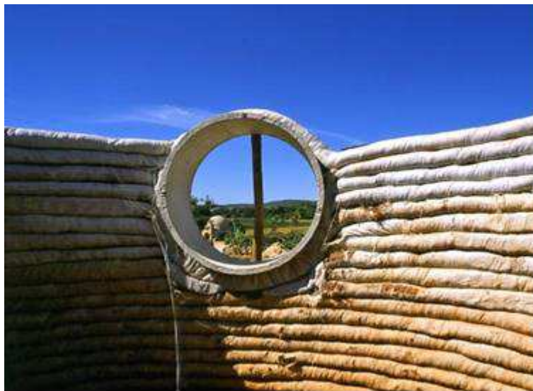
Figura 29 – Vão com manilha em parede de superadobe
