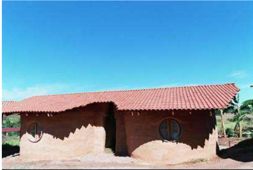
Figura 30 – Construção com superadobe concluída
