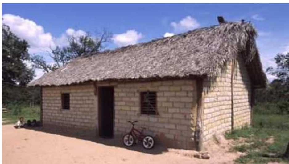
Figura 24 – Construção com tijolos de adobe concluída
