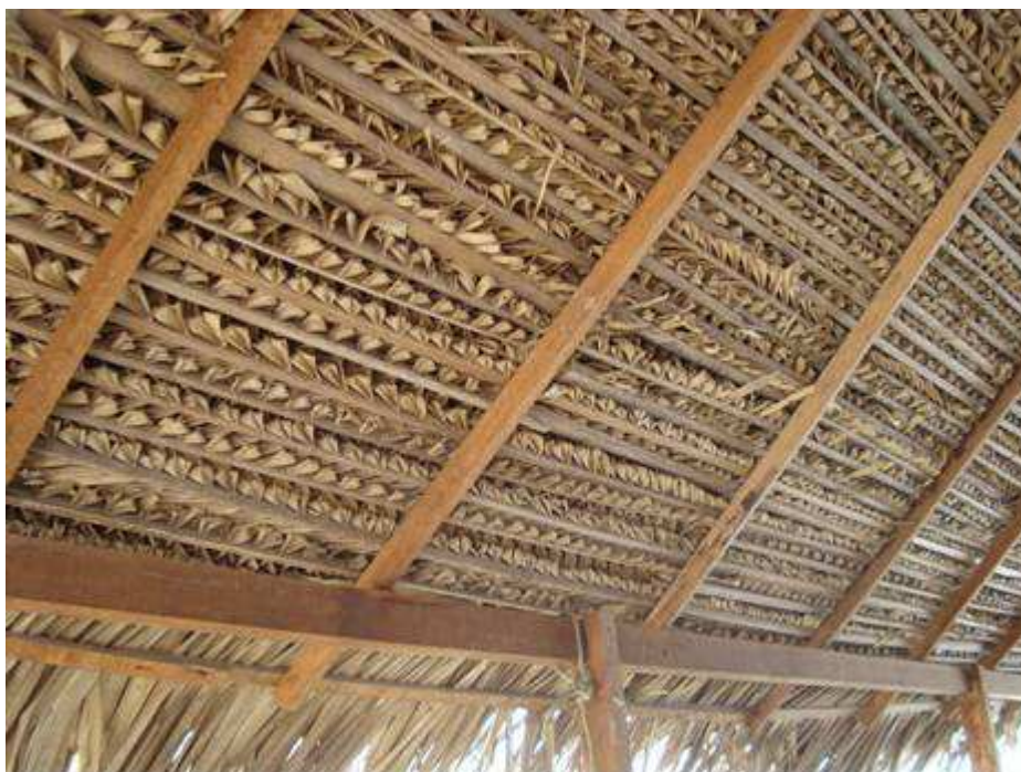
Figura 5 – Cobertura com palha de coqueiro trançada fixada com pregos ao madeirame FONTE: Fotos do autor
