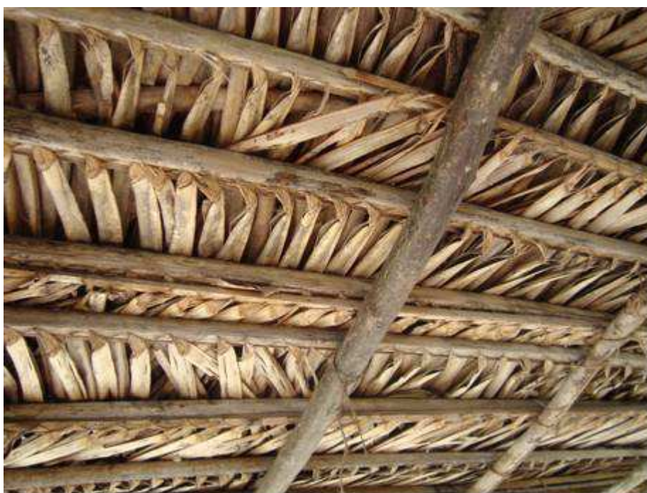
Figura 4 – Cobertura com palha de coqueiro lisa fixada ao madeirame do telhado com cordão de sisal
