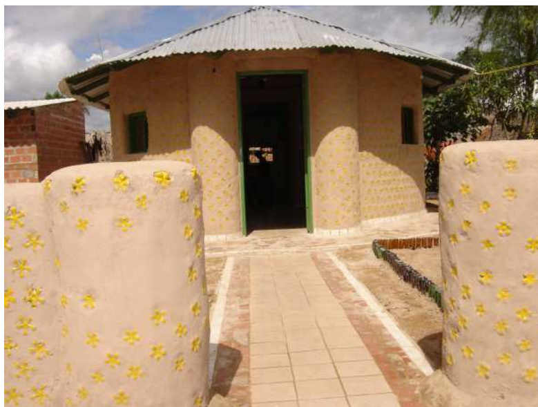
Figura 13 – Aspecto da obra concluída com garrafas PET dispostas horizontalmente em meio à argamassa 3 FONTE: Severiano (2010)
