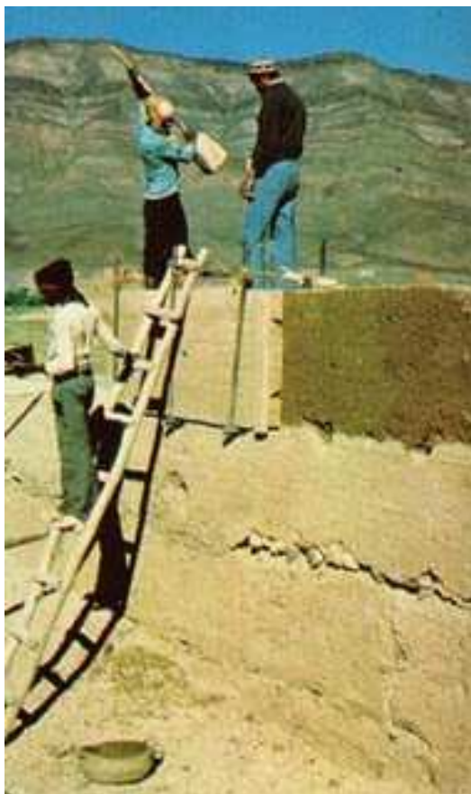
Figura 20 – Estrutura do taipal, na segunda fiada de uma construção de taipa de pilão
