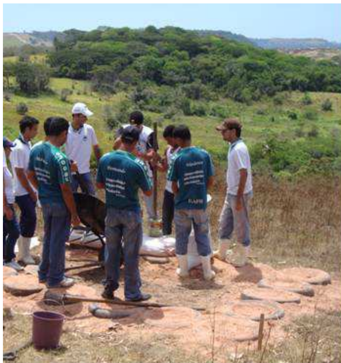
Figura 15 – Base de aprisco em construção, feita com pneus usados 4
