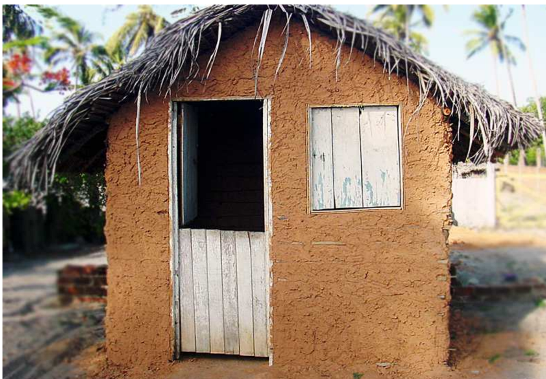
Figura 19 – Construção de pau-a-pique com cobertura de palha de coqueiro
