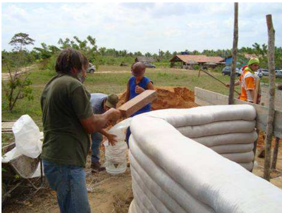
Figura 9 – Morador da comunidade pilando a lateral de saco de ráfia longo 2 FONTE: Fotos do autor
