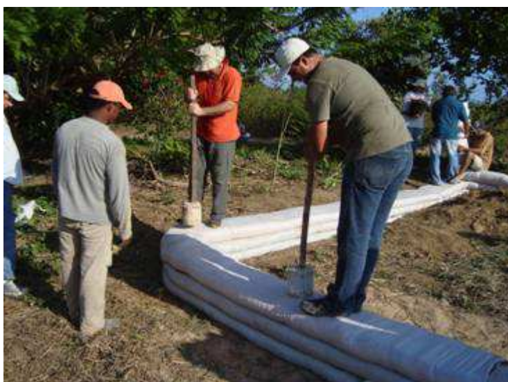
Figura 8 – Pilagem de saco de ráfia longo 1 FONTE: Fotos do autor
