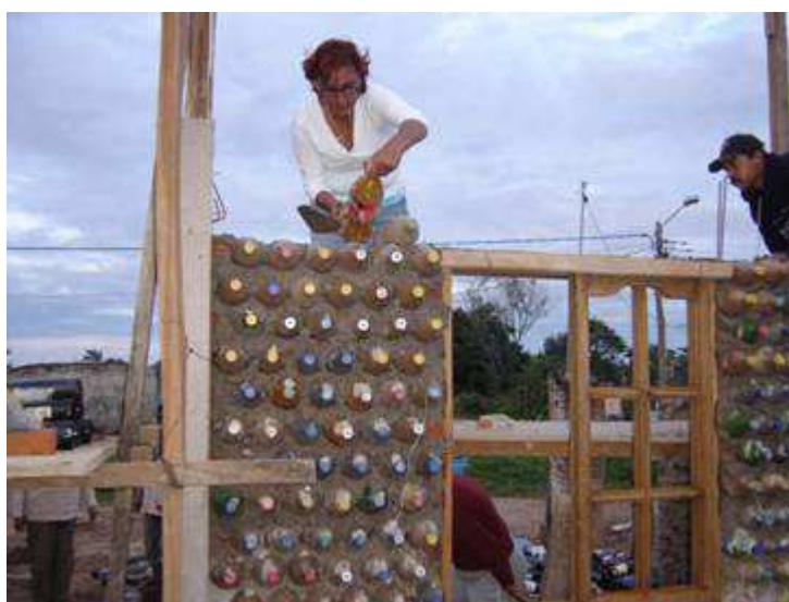
Figura 11 – Construção de parede com garrafas PET dispostas horizontalmente em meio à argamassa
