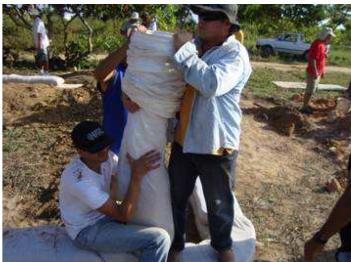
Figura 7 – Preenchimento de saco de ráfia longo, com auxílio de balde sem fundo FONTE: Fotos do autor
