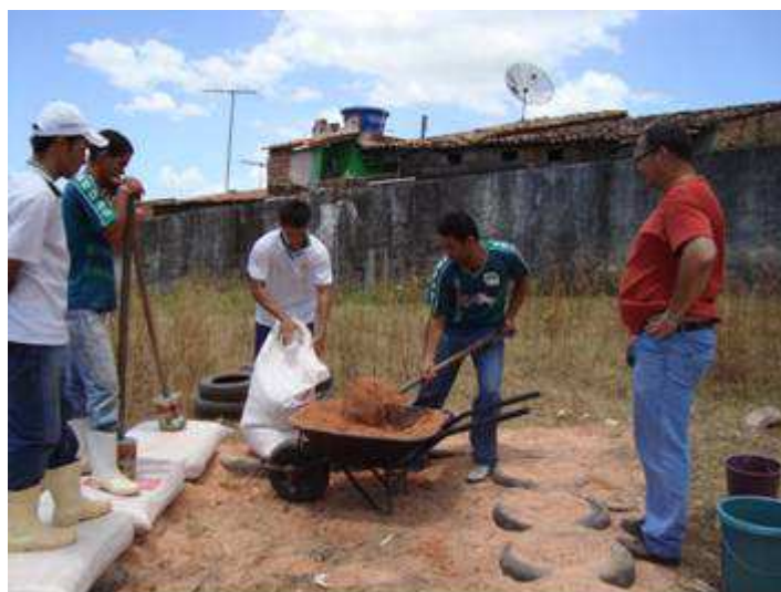
Figura 6 – Preenchimento de saco de ráfia de 60 kg, diretamente com pá FONTE: Fotos do autor
