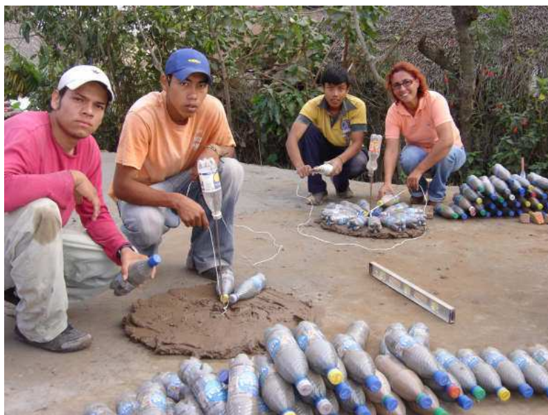
Figura 12 – Construção de base de coluna com garrafas PET dispostas horizontalmente em meio à argamassa FONTE: Severiano (2010)
