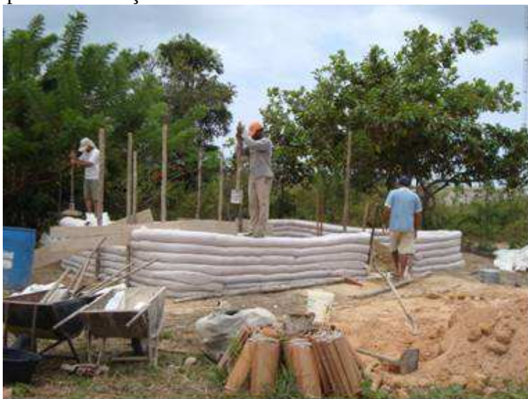
Figura 28 – Pilamento dos sacos de ráfia de superadobe 6
