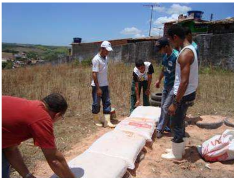
Figura 26 – Alinhamento da primeira fieira de construção com superadobe FONTE: Foto do autor
