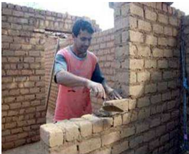
Figura 23 – Assentamento dos tijolos de adobe com a mesma massa que os constituem FONTE: Vicelmo (2008)
