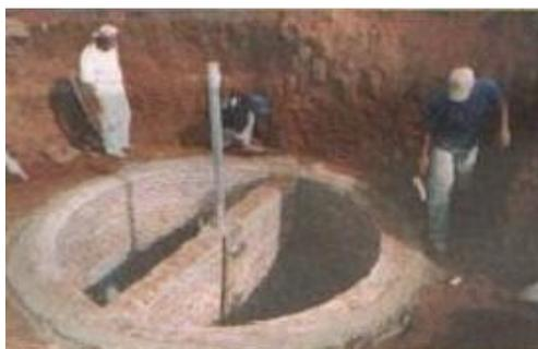
**Figura 14:** Fase de construção do biodigestor
