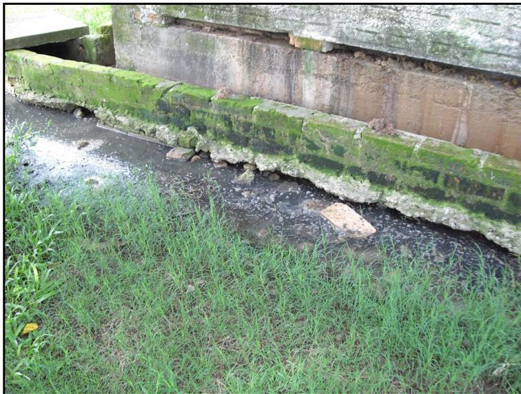
**Figura12** – Canaletas, a céu aberto, e vazamentos causando poluição do solo.
