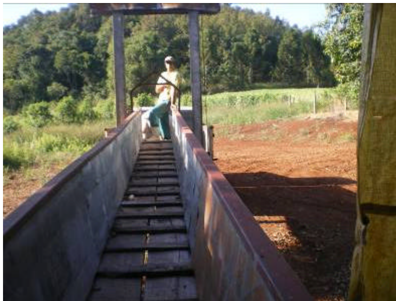
Figura 9 - Plataforma (rampa) com elevação de embarque e desembarque com travas antiderrapantes.
