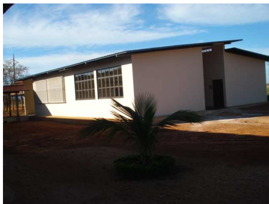
Figura. Bloco de Sala de Aula
