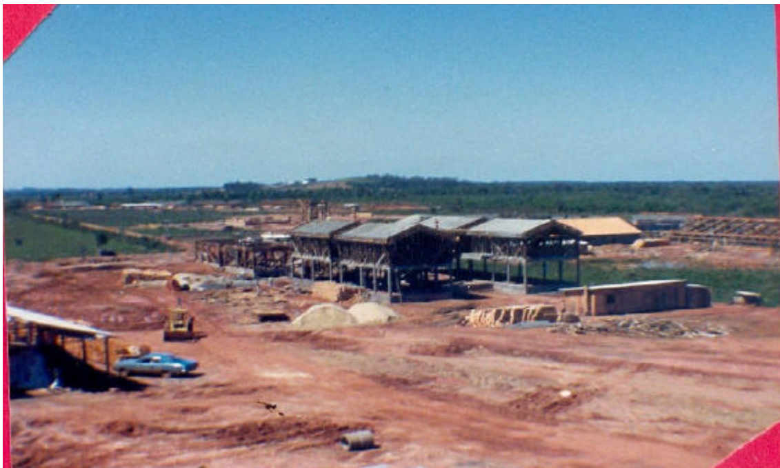
Figura 3 - Aspecto parcial do início da construção da escola na segunda metade da década de 1980. Fonte: Fototeca do Instituto Federal Catarinense - Campus Sombrio.
