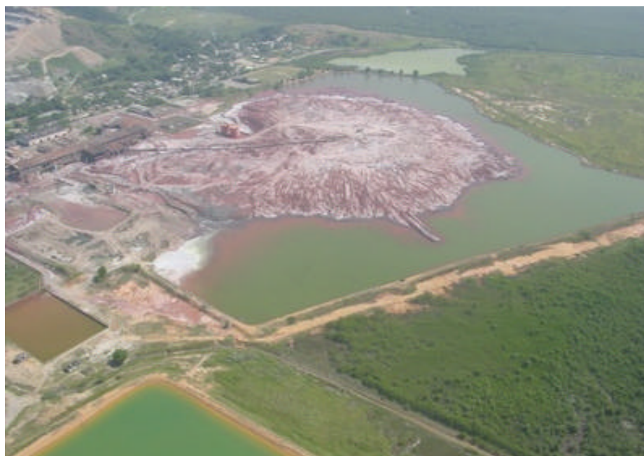
Figura 1: Vista aérea da montanha de resíduo Ingá e da lagoa de contenção.
